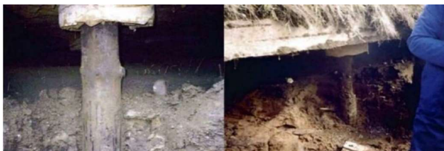
1-15.att. Tukšums zem uzbēruma plātnes
