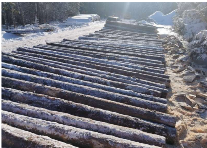
2-4.att. Kokmateriālu novietojums uz pāļu sagatavošanas platformas
