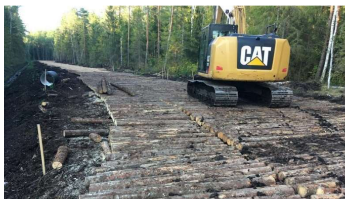
2-2.att. Sīkbaļķu klājumu izbūve objektā 2019.gadā
