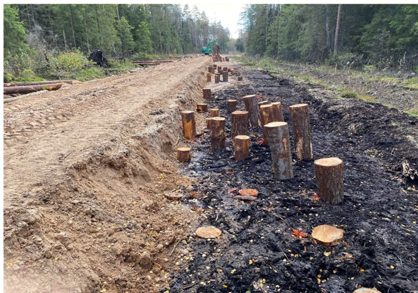
2-14.att. Koksnes pāļu izbūve un atkoda sasniegšana no PK 02+50 līdz PK 03+50.
