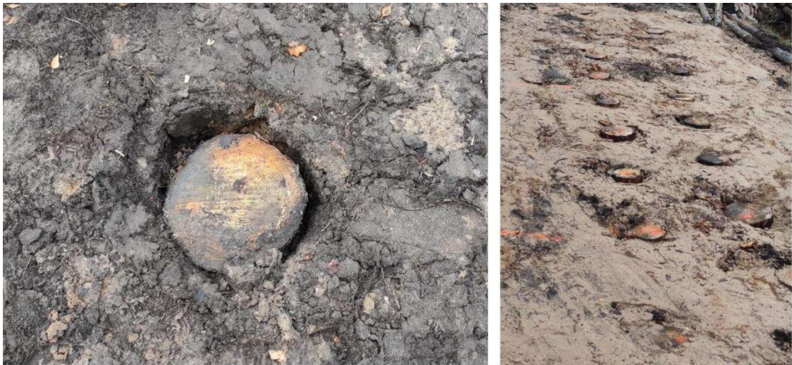
2-12.att. Grunts kustība ap pāli dzīšanas laikā
