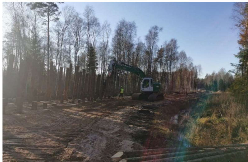
2-10.att. Pāļu vienā no ceļa brauktuves pusēm tehnikai, atrodoties uz sīkbaļķu klājuma
