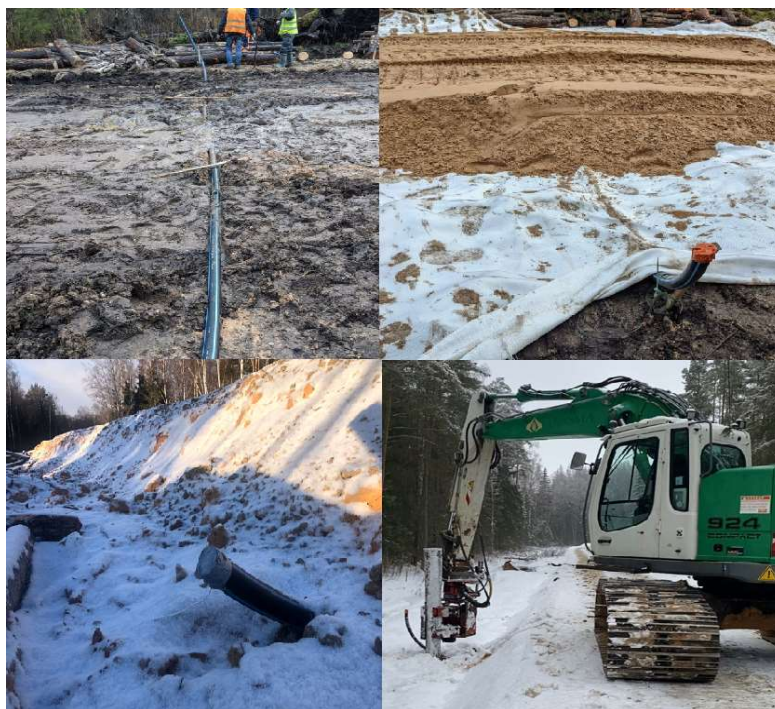
3-4.att. Vertikālo deformāciju novērojumu sistēmas izbūves process būvobjektā:
