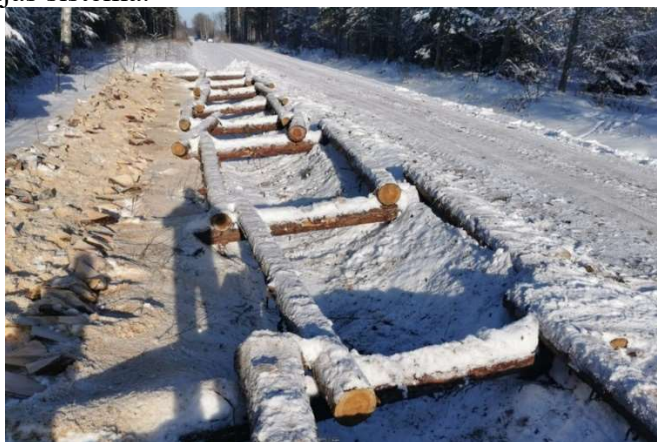
2-3.att. Pāļu sagatavošanas platforma objektā
