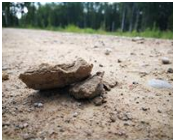
6-13. attēls. Ar lignosulfonātu atputekļotā grants seguma virsmas “garoza” ceļa 4. posmā (a) un 5. posmā (b).
