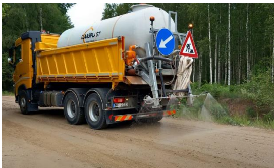
5-5. attēls. Grants seguma laistīšana/mitrināšana (a) un profilēšana (b).
