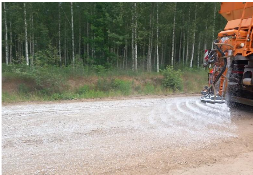
5-6. attēls. Kalcija hlorīda iestrāde (izkaisīšana).
