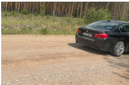
6-24. attēls. Abermaņa meža ceļš 1. monitoringā 13.07.2023., ja braukšanas ātrums ir 30 km/h: (a) neatputeķlots; (b) atputeķlots ar lignosulfonāta standarta devu.
