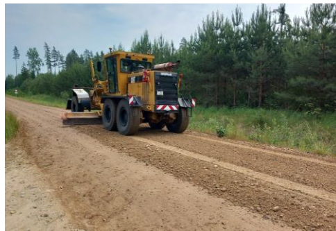
5-5. attēls. Grants seguma laistīšana/mitrināšana (a) un profilēšana (b).
