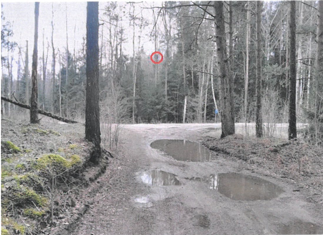
1. attēls. Ceļš no karjera, Vecvārnu ceļš pie vistu vanaga ligzdas (sarkanais aplis) (A. Kalvāns foto 08.03.2019.)
