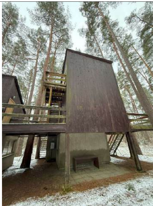
4.16.2 att. Apdares dēļi, kam jāveic apdares atjaunošana
