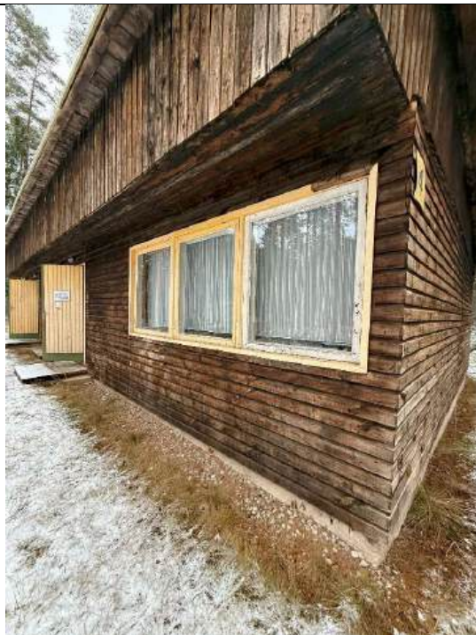
4.16.2 att. Apdares dēļi kuriem jāveic apdares atjaunošana un nomaiņa
