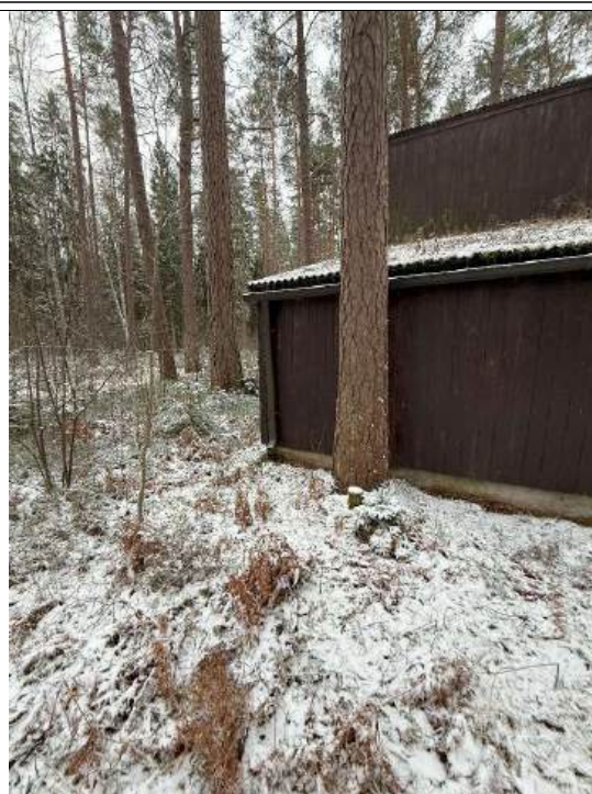
4.8.2 att. Veikt jumta segumu attīrīšanu
