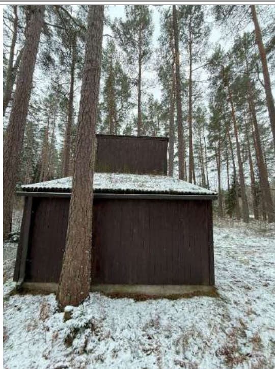
4.8.1 att. Veikt jumta segumu attīrīšanu
