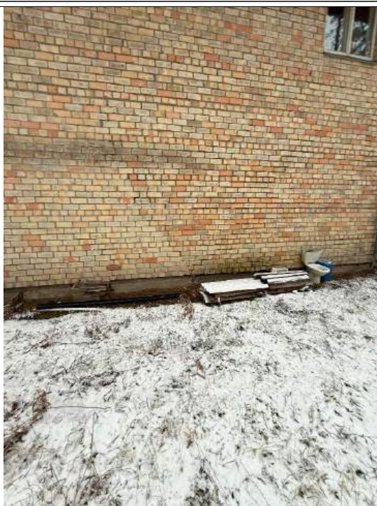
4.16.1 att. Ārējā apdare no eksponēta ķieģeļa
