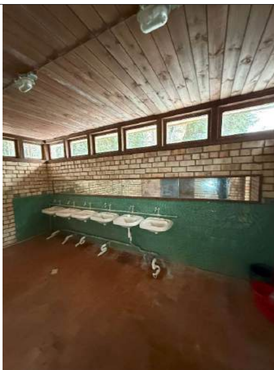
4.16.2 att. Aukstā ūdens un kanalizācijas cauruļvadi. Kanalizācijas cauruļvadi demontēti
