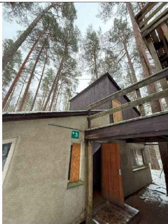
4.12.1 att. Koka ārdurvis un logi, kas jāmaina
