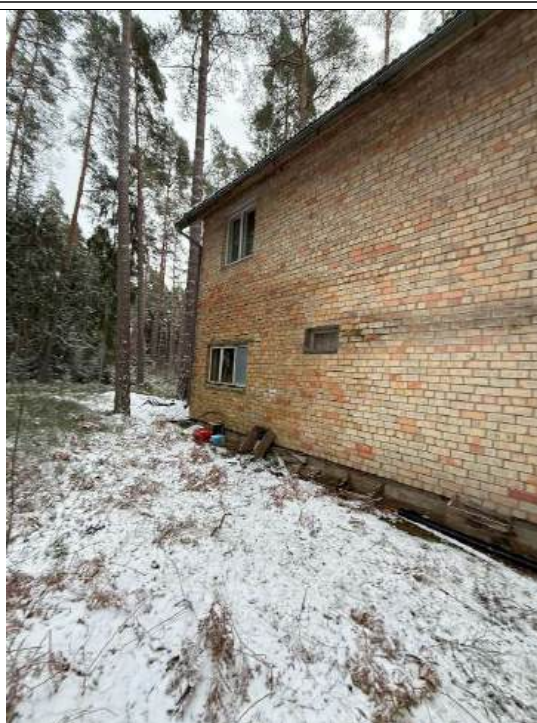
4.16.2 att. Ārējā apdare no eksponēta ķieģeļa
