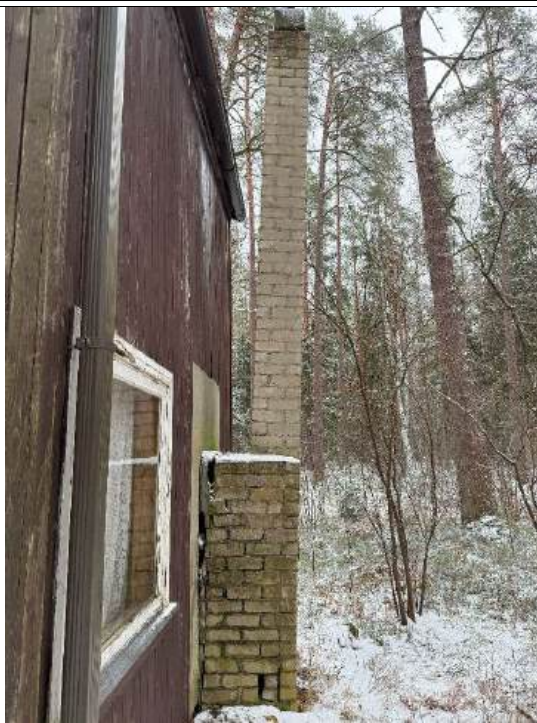
4.14.1 att. Skursteņa izvads, kas atdalās no mājas un būtu jāveic to pārmūrēšana
