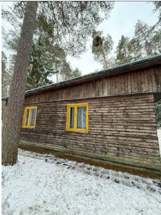
4.16.1 att. Apdares dēļi kuriem jāveic apdares atjaunošana un nomainīa
