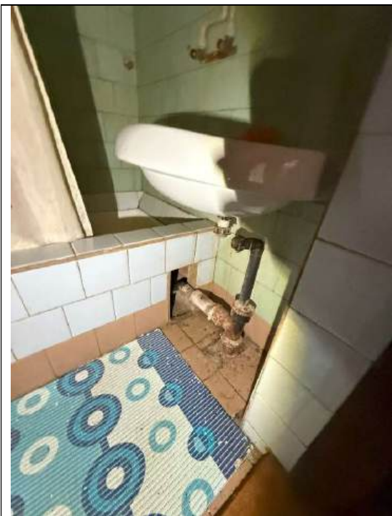
5.1.1 att. Kanalizācijas cauruļvadi, kas nav mainīti
