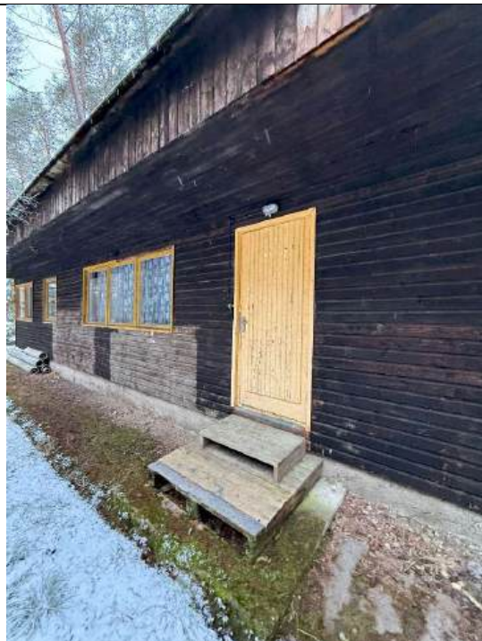
4.16.1 att. Apdares dēļi kuriem jāveic apdares atjaunošana un nomaiņa
