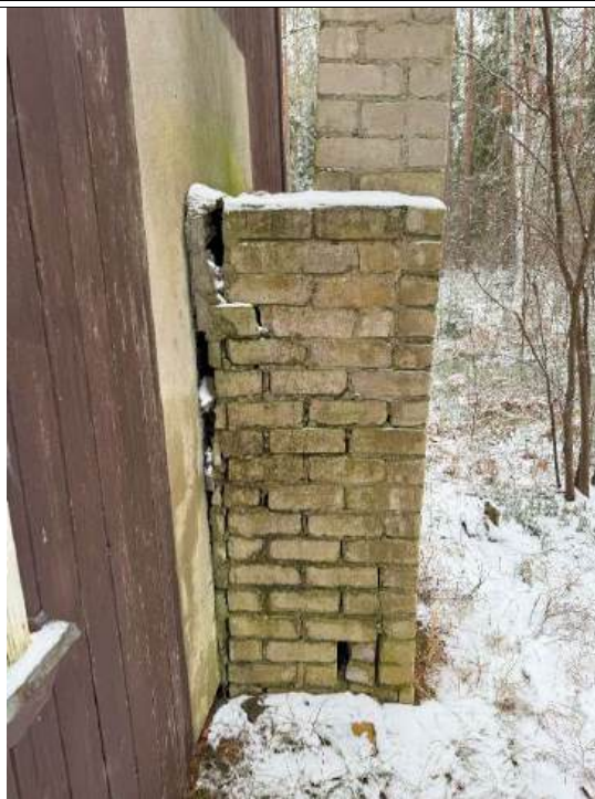
4.14.2 att. Skursteņa izvads, kas atdalās no mājas un būtu jāveic to pārmūrēšana
