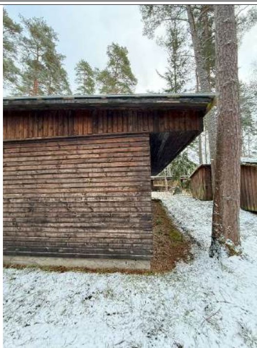
4.8.2 att. Jumta segums no metāla loksnes, zem kuras nav izbūvēta pretkondensāta plēve kā arī bez lietus ūdens novadišanas sistēmas
