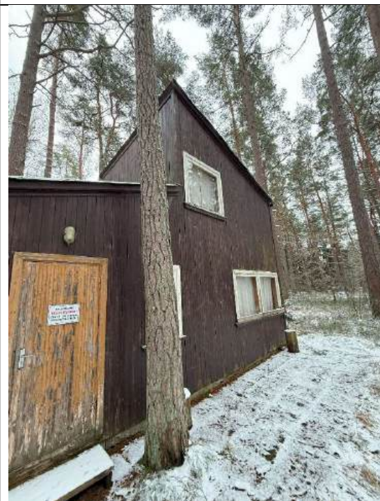
4.12.1 att. Koka ārdurvis un logi, kam jāveic apdares atjaunošana
