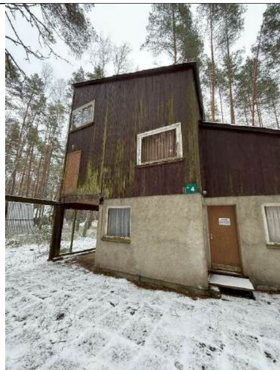
4.12.1 att. Koka ārdurvis un logi, kas jāmaina
