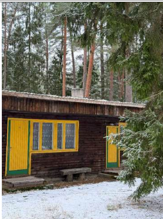
4.14.2 att. Ventilācijas kanāls, kas jāatjauno virs jumta līmeņa
