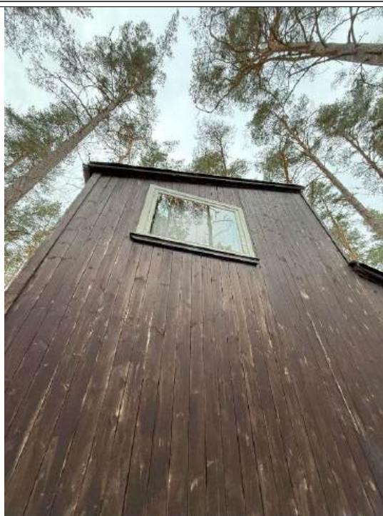
4.16.2 att. Apdares dēļi, kam jāveic apdares atjaunošana
