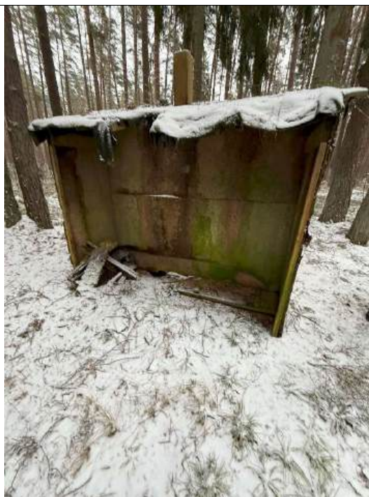
4.8.2 att. Sabrucis jumta segums
