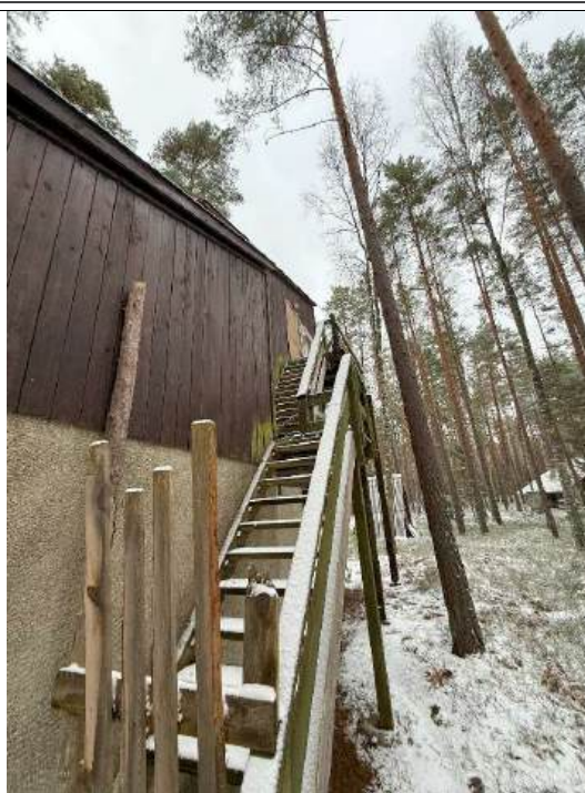
4.10.4 att. Koka ārējās kāpnes, kas ved uz trešo stāvu, kuras ir jāmaina
