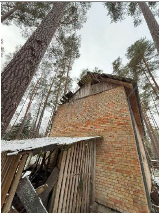
4.8.3 att. Jumta seguma un klāja konstrukcijas, kas ir sabrukušas
