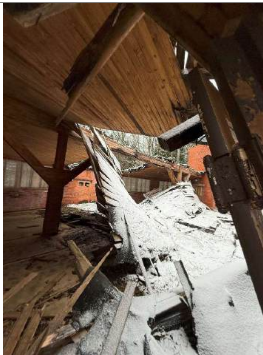
4.8.4 att. Sabrukusi jumta konstrukcija
