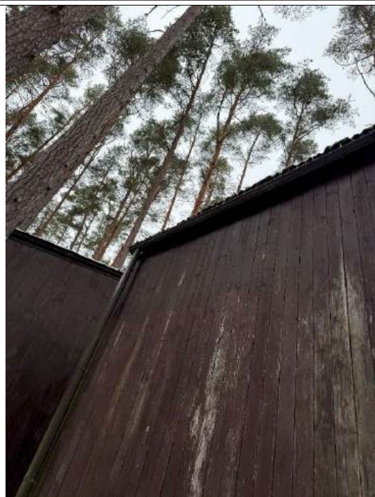
4.8.1 att. Jumta segums, kas jaattīra un lietus ūdens novadišanas sistēma
