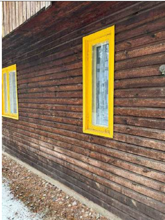
4.16.2 att. Apdares dēļi kuriem jāveic apdares atjaunošana un nomainīa
