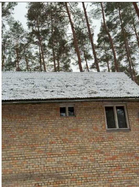
4.8.2 att. Azbestcimenta jumta segums, kas nav notīrīts un lietus ūdens novadīšanas sistēma, kas nepilda savu funkciju
