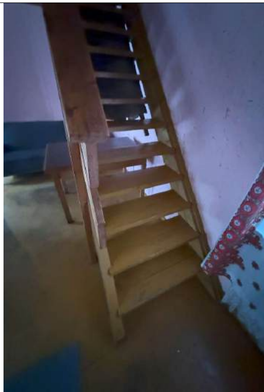
4.10.2 att. Koka kāpnes, kas ir slēgtas un ved uz trešo stāvu
