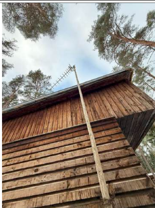
4.8.1 att. Jumta segums no metāla loksnes, zem kuras nav izbūvēta pretkondensāta plēve kā arī bez lietus ūdens novadišanas sistēmas
