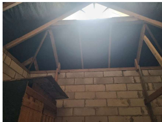
4.8.2. att. Jumta nesošās konstrukcijas
