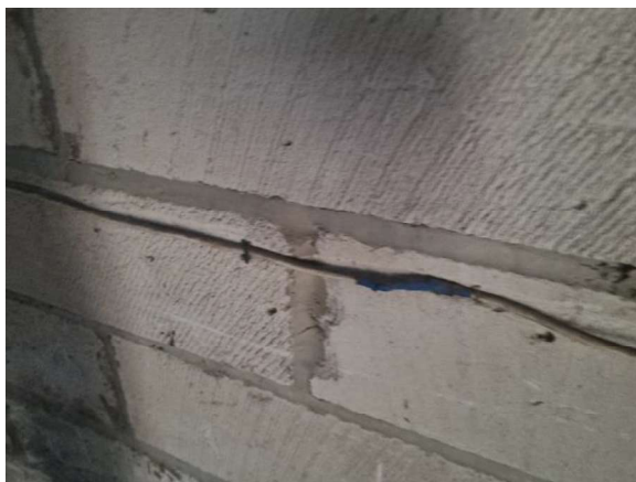
5.9.1. att. Labota kabeļa izolācija
