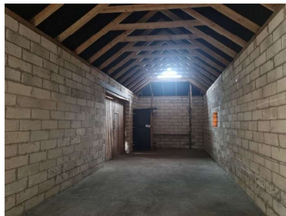
4.12.2. att. Betona grīdas segums
