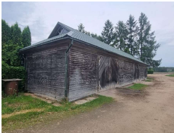
2.2.2.att. Skats uz ēku no dienvidaustrumu puses
