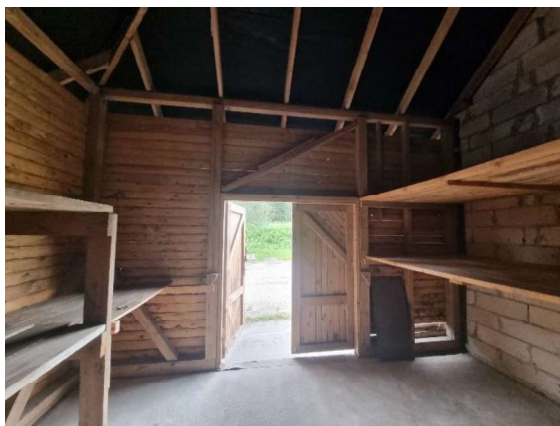
4.12.1. att. Betona grīdas segums
