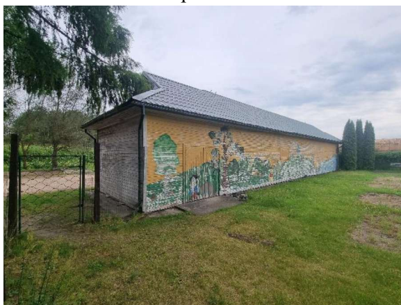
2.2.4.att. Skats uz ēku no ziemeļrietumu puses
