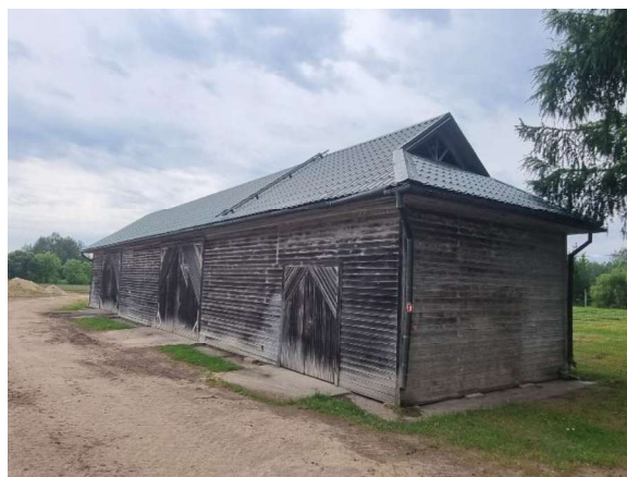
2.2.5.att. Skats uz ēku no ziemeļaustrumu puses
