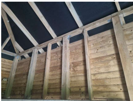
4.8.3. att. Jumta nesošās konstrukcijas šķūņa daļā
