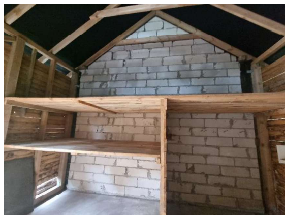
4.2.6. att. Skats uz koka karkasa ārsienām šķūņa daļā
