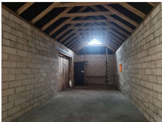
4.2.1. att. Skats uz ēkas nesošām sienām
