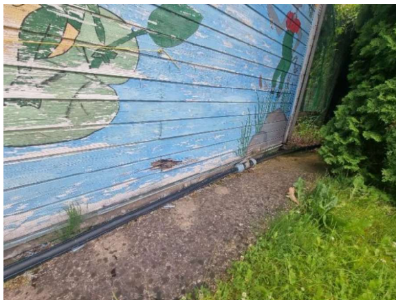
4.1.1. att. Skats uz ēkas pamatiem cokola līmenī
