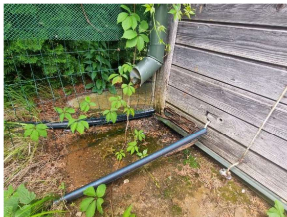
4.19.2. att. Apšuvuma dēļiem radušies trūpes bojājumi
