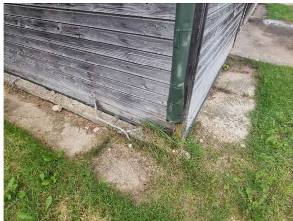
4.1.2. att. Skats uz ēkas pamatiem cokola līmenī
