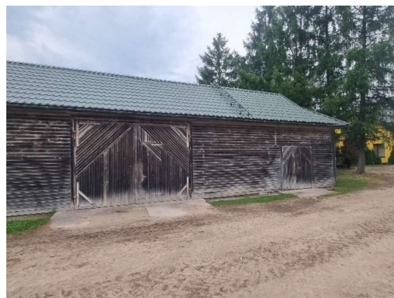
4.13.2. att. Koka konstrukcijas veramie vārti
