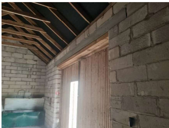
4.2.5. att. Ailu pārsedzes bez būtiskiem bojājumiem
