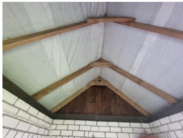
4.8.2. att. Jumta nesošās konstrukcijas
