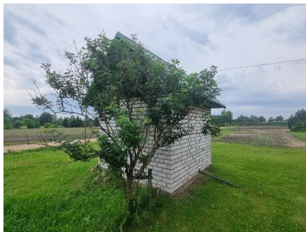
2.2.5.att. Skats uz ēku no ziemeļaustrumu puses
