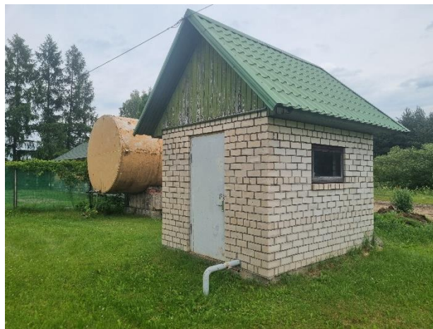
2.2.3.att. Skats uz ēku no dienvidrietumu puses
