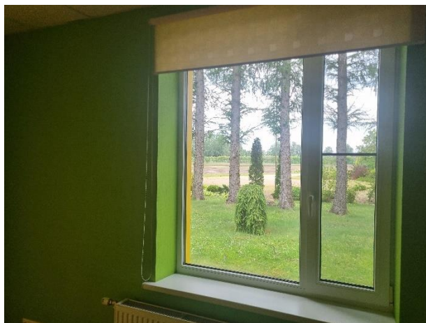
4.13.1. att. Stikla pakešu logs ar PVC rāmi
