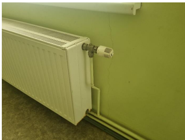
5.5.1 att. Apkures sistēmas tērauda konvektori
