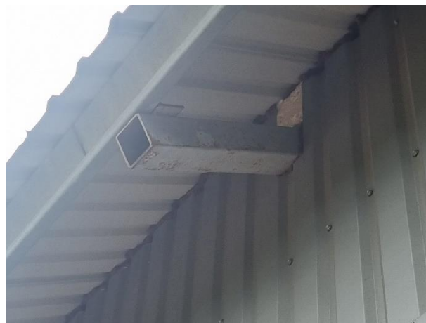
4.5.2. att. Sienas un jumta konstrukciju savienojuma vieta hermetizēta ar celtniecības putām
