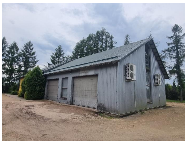
2.2.5.att. Skats uz ēku no ziemeļaustrumu puses
