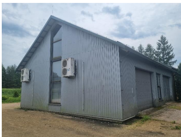
2.2.4.att. Skats uz ēku no ziemeļrietumu puses
