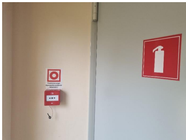
5.3.2. att. Ugunsgrēka trauksmes signalizācijas iedarbināšanas poga
