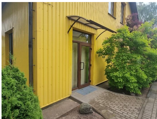
4.9.1. att. Polikarbonāta jumtiņu virs ieejas durvīm
