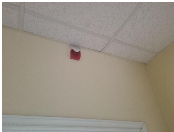
5.3.8. att. Ugunsgrēka trauksmes signalizācijas sirēna
