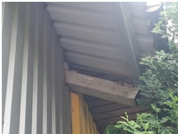
4.8.2. att. Jumta nesošās konstrukcijas virs noliktavas daļas
