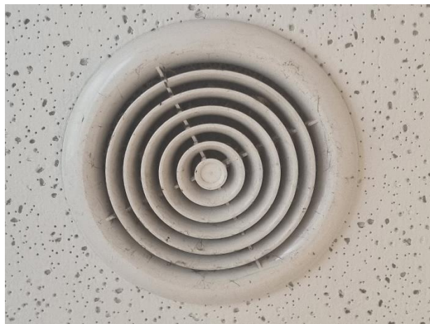
5.6.2. att. Nosūces difuzors dušās telpā
