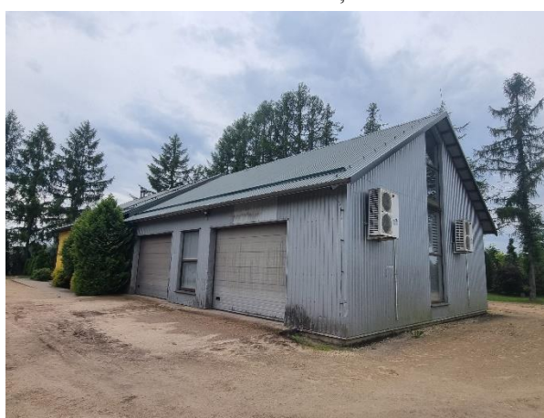
4.8.4. att. Jumta segums virs noliktavas daļas
