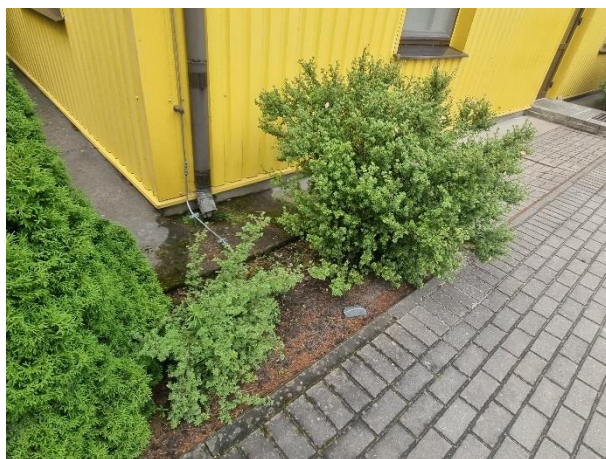
4.1.1. att. Skats uz ēkas pamatiem cokola līmenī
