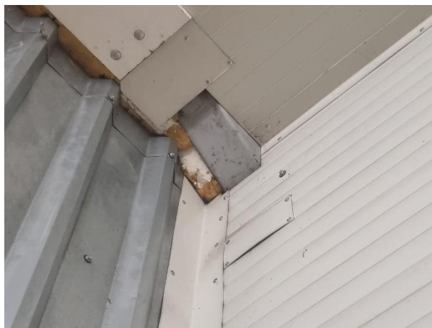
4.5.1. att. Sienas un jumta konstrukciju savienojuma vieta hermetizēta ar celtniecības putām
