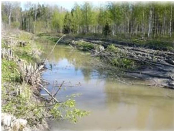
Attēls 3. Pastiprināta sedimentu iznese meliorācijas sistēmu renovācijas darbu rezultātā
