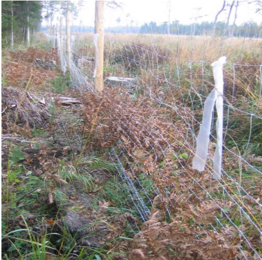
10.attēls. Deformēts žoga siets pēc brieža ieskriešanas tajā.
