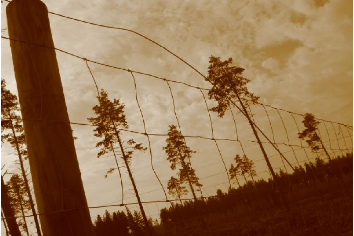
9.attēls. Augšējās stieples pārrāvums Silenes iecirkņa 202.kvartāla cirsmas iežogojumam.
