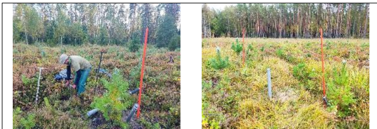
Att. 1.28. Gruntsūdens aku un sakņu cauruļu ierīkošana Lubānas iecirknī
