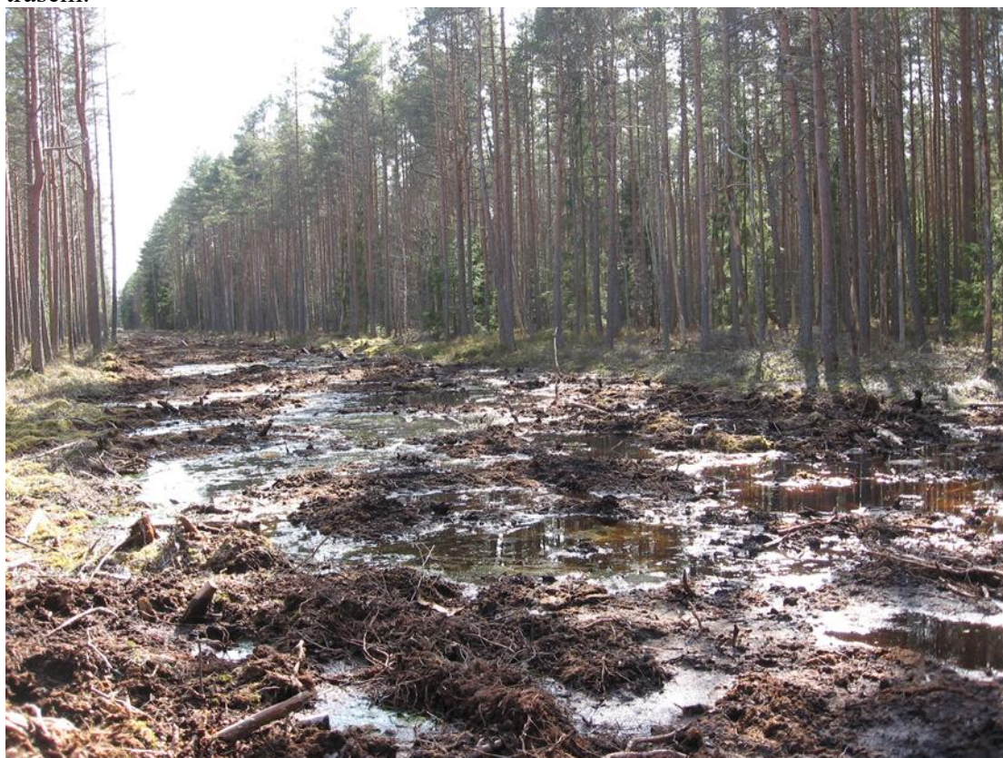
3.1.2.2.attēls. Aizbērtā grāvja trase 2018.gada 20.aprīlī (Foto: K.Liepiņš)
